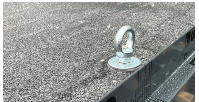
Detail Transportösen am Dach der Gartensauna LUNA
