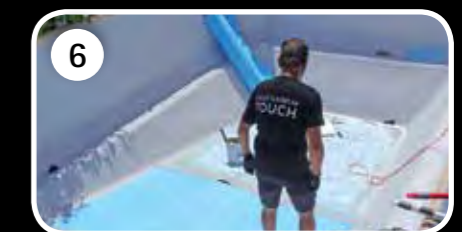
Boden stumpf oder überlappend verlegen.
