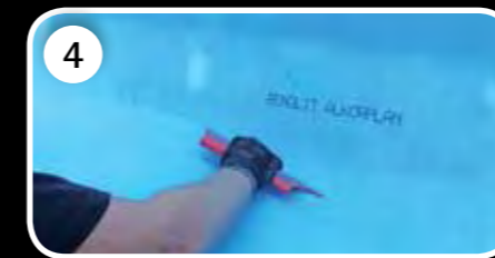
RENOLIT ALKORPLAN Vlies anbringen, im Fall von Osmose mit Blasen und Flüssigkeit.
