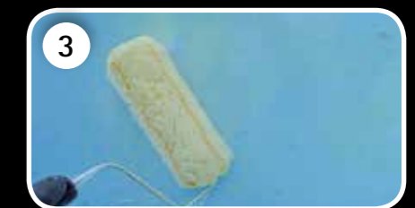
RENOLIT ALKORGLUE Kontaktkleber vollflächig auftragen.
