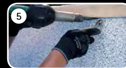
Wände mit RENOLIT ALKORPLAN TOUCH auskleiden.
